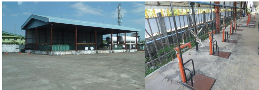
タンク(22トン×2基)・充填設備はあるが年に1回政府の輸入用に貸与するのみ。
